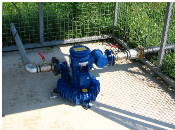
Sl. 3: Duvaljka sa bočnim kanalom
