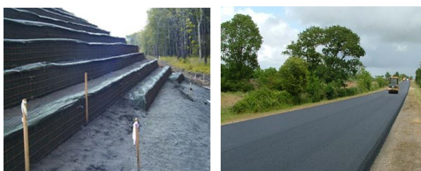
Slika 2.7: Primena fabričkog peska u izgradnji stepenastog nasipa i asfaltnog puta
