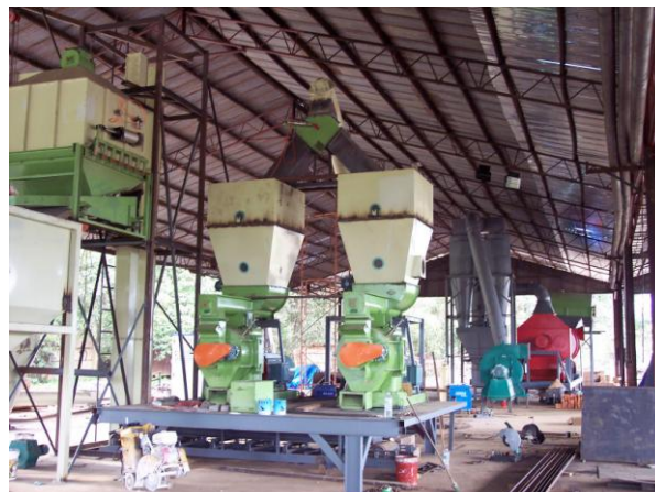
Sl. 4. Montaža opreme u pogonu za peletiranje
