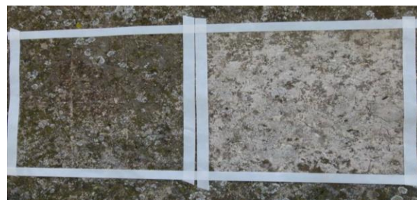
Sl. 7. Praćenje efikasnosti, trajnosti i kompatibilnosti materijala za samočišćenje na zidanim strukutrama tvrđave u Baču
